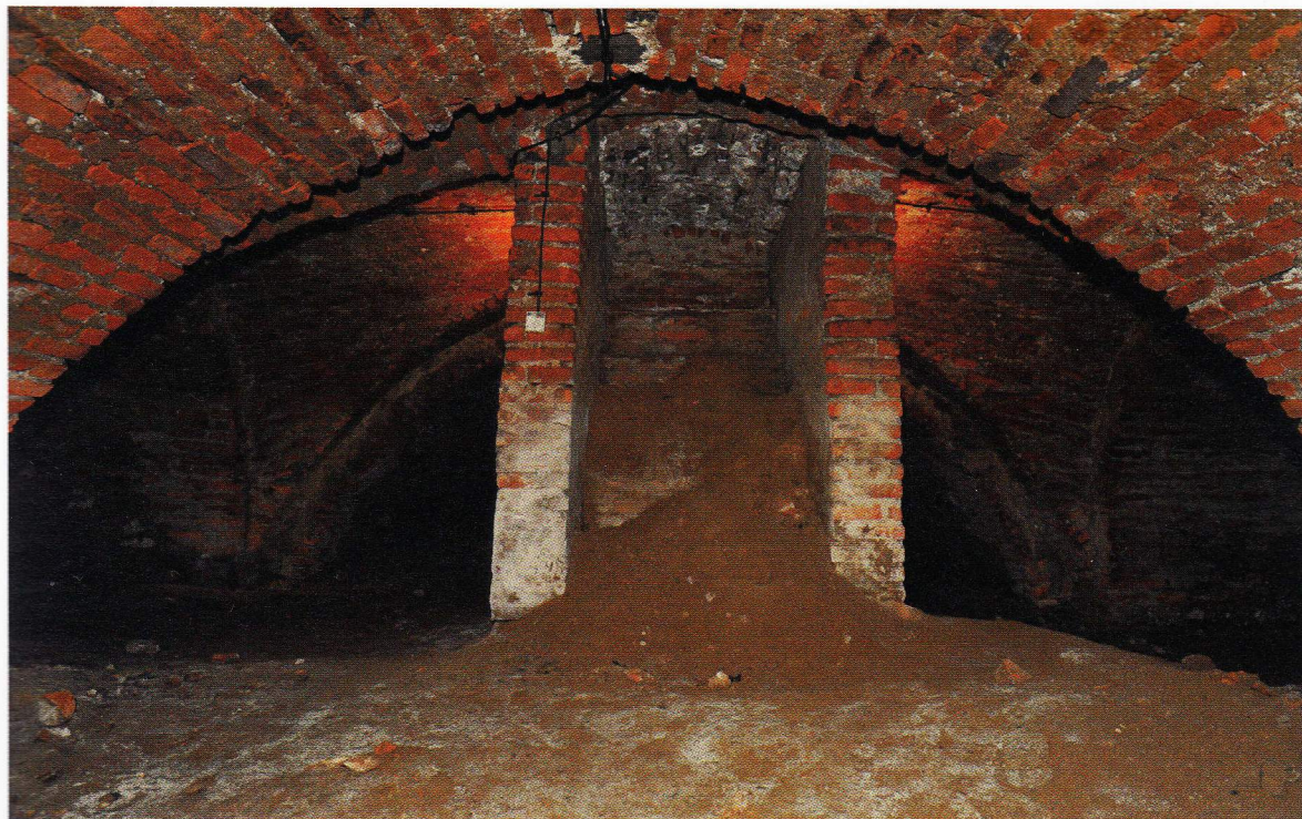
Ryc. 6. Krypta centralna, widok na schody przed podjęciem badań archeologicznych i prac remontowych (fot. z archiwum archikatedry)
